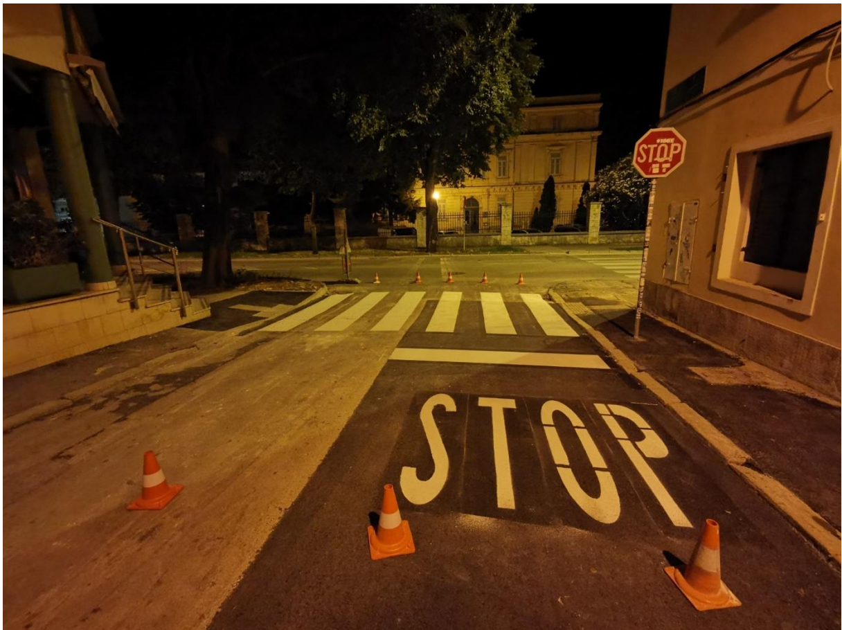
Slika 26: Radnička ulica, obnova nakon radova (Izvor: fotografirao autor)
