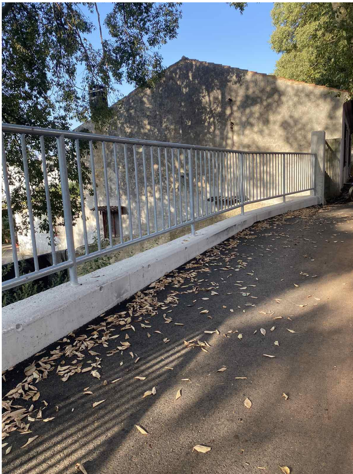
Slika 54: Mutilska ulica, izrada i montaža pocinčane ograde (Izvor: fotografirao autor)
