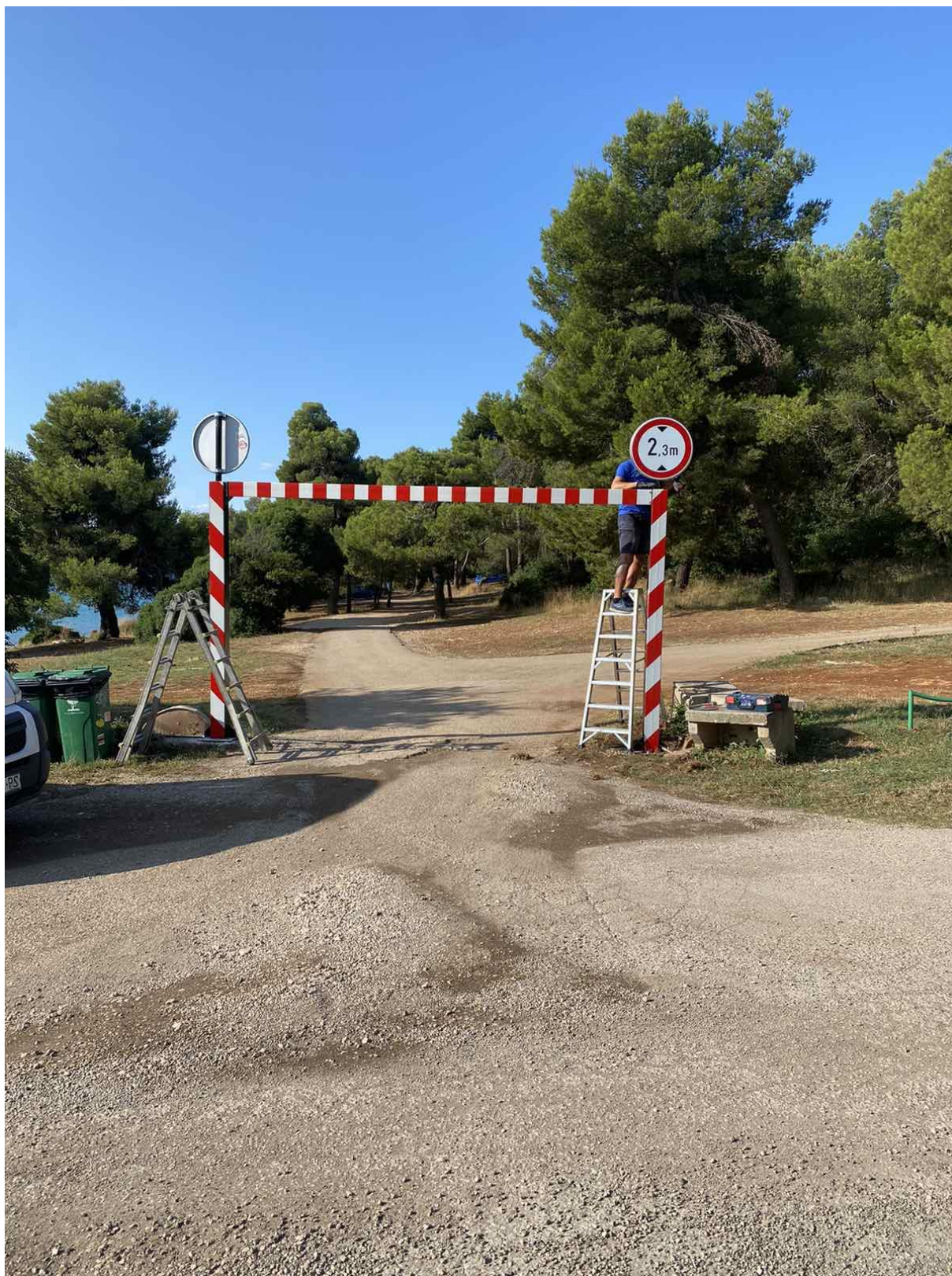
Slika 52: Stoja: izrada i montaža visinske barijere (Izvor: fotografirao autor)
