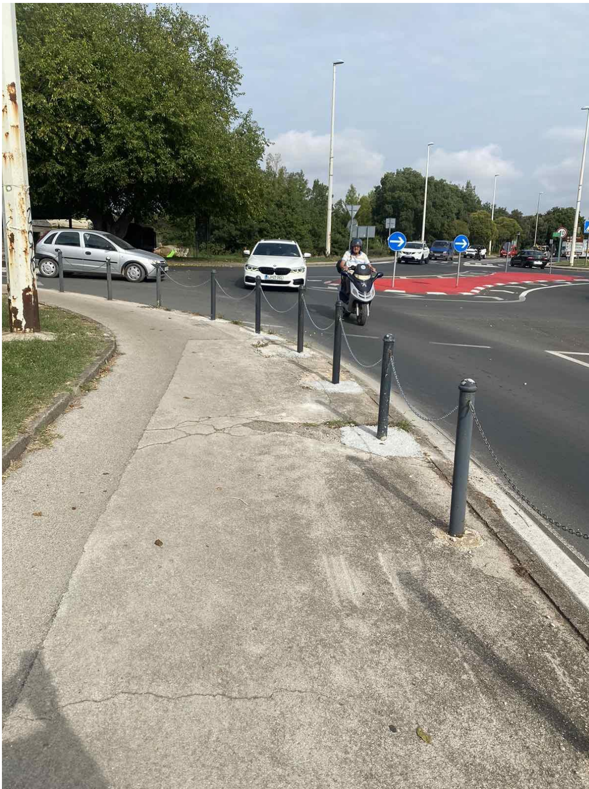
Slika 30: Vodnjanska cesta, ugradnja stupića i postava lanca nakon prometne nezgode (Izvor: fotografirao autor)
