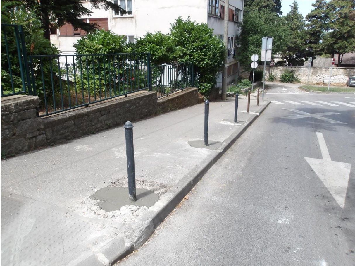
Slika 36:Boškovićevo uspon, postava novih stupića i sanacija nogostupa (Izvor: fotografirao autor)
