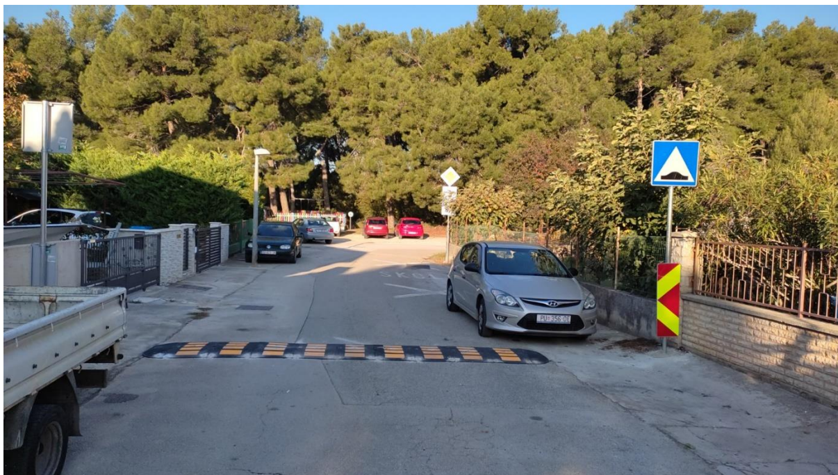
Slika 9. Montaža umjetnih izbočina
