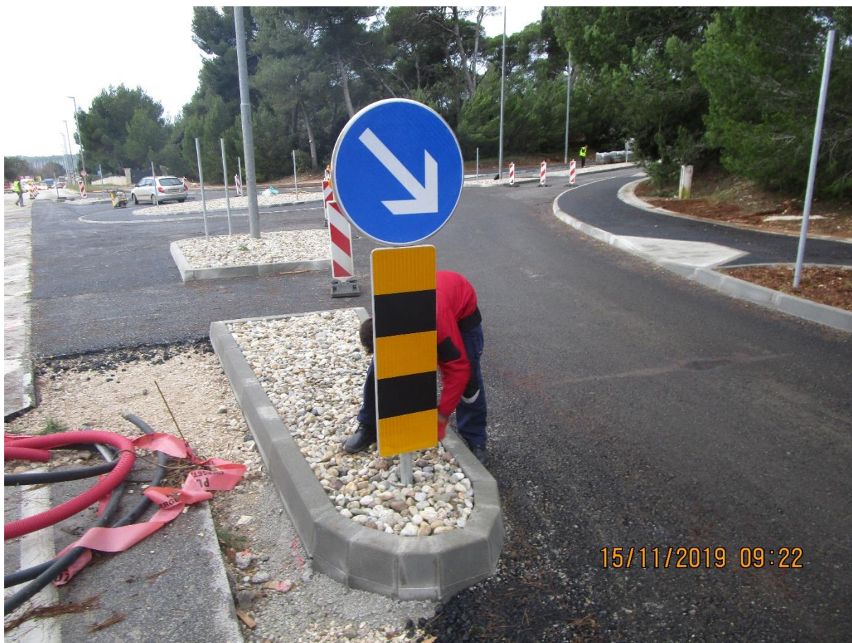
Slika 7. Montaža znaka B47, K05
