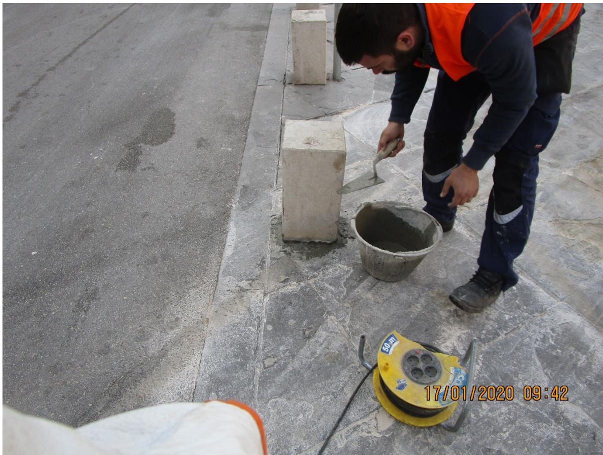
Slika 5.ugradnja kamene prizme
