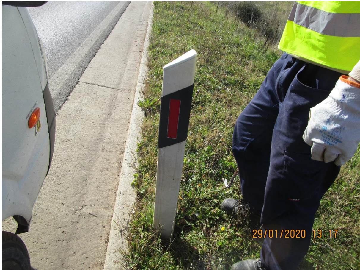
Slika 13. Ugradnja smjerokaznog stupa K01
