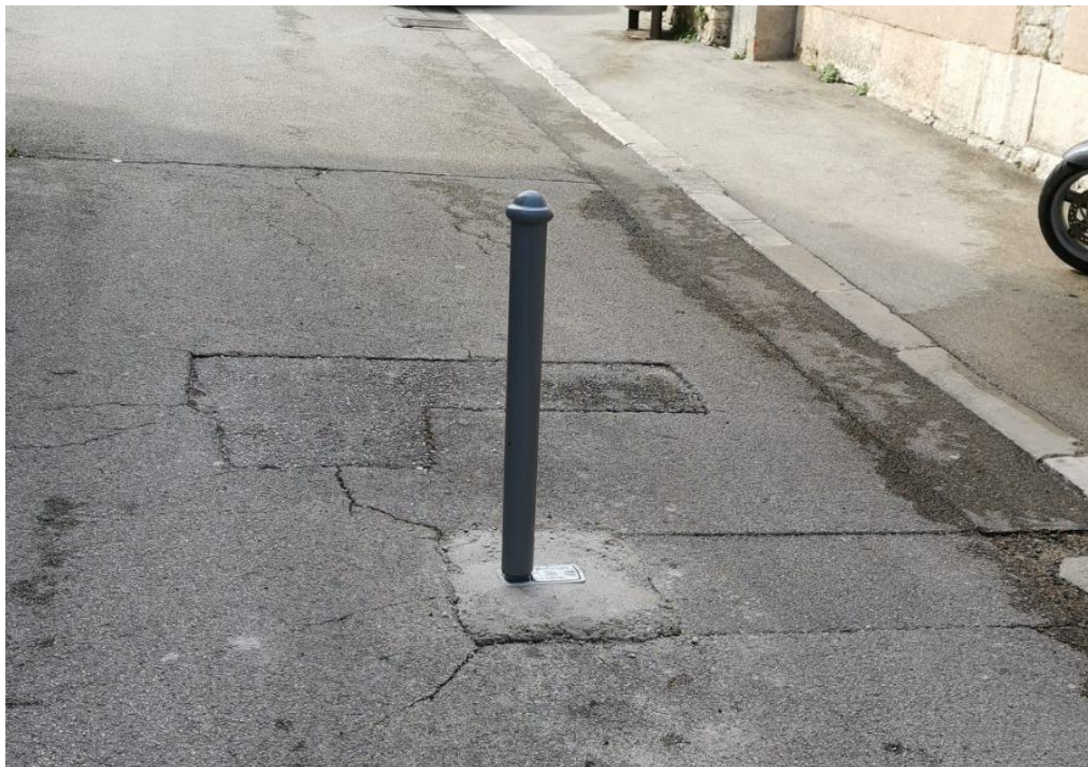
Slika 7. postavljeni stupić s čahurom na Trgu Sv. Tome
