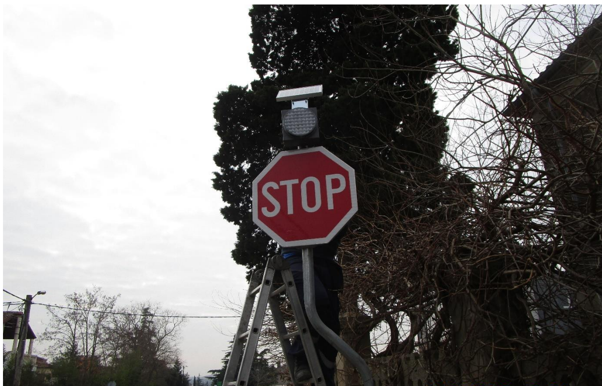
Slika 9. prometni znak B02 sa solarnim treptačem
