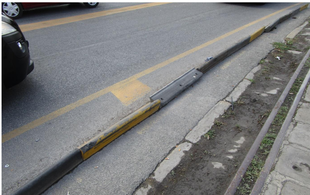
Slika 15.postava montažnih rubnjaka K21
